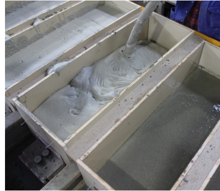
Abbildung 29: Einbringen des mineralisierten Dämmschaums.
