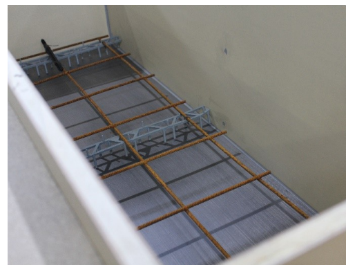
Abbildung 27: Bewehrung der Vorsatzschicht.
