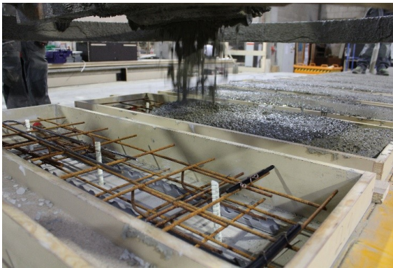
Abbildung 36: Betonage der Tragschicht mit Betonierkübel.
