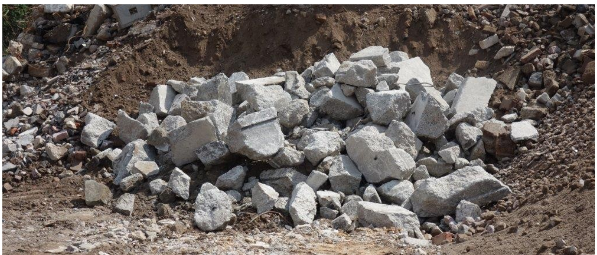
Abbildung 2: Abbruch der Brückenkappe.
