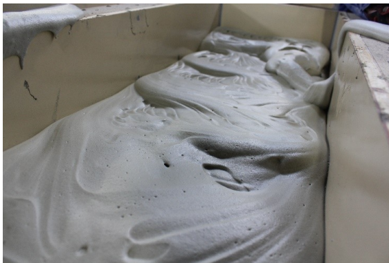
Abbildung 30: Eingebrachter mineralisierter Dämmschaum.
