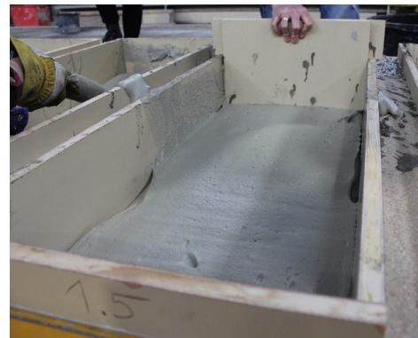
Abbildung 31: Abzug des mineralisierten Dämmschaums.
