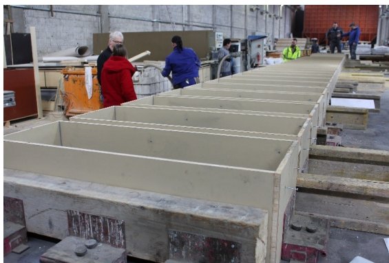
Abbildung 26: Schalungen auf dem Rütteltisch.
