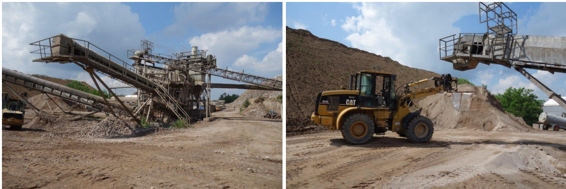
Abbildung 3: Anlage SHW Messel.
