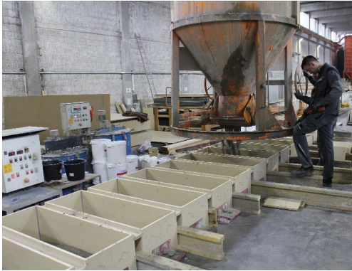
Abbildung 28: Betonage der Vorsatzschicht mit Betonierkübel.
