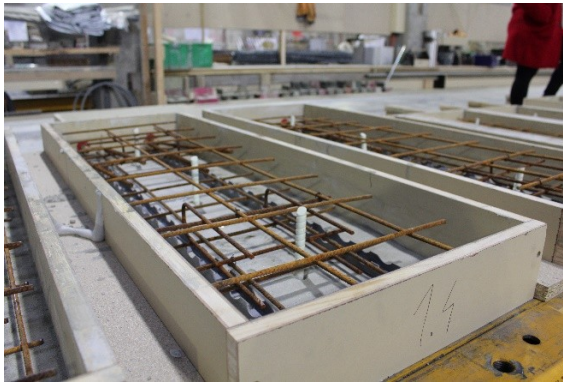
Abbildung 34: Bewehrung der Tragschicht.
